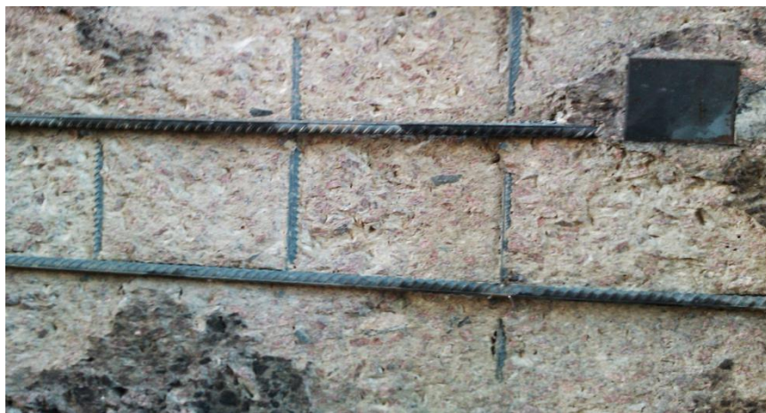
Рис. 5. Изменение цвета арматуры в результате воздействия высоких температур
